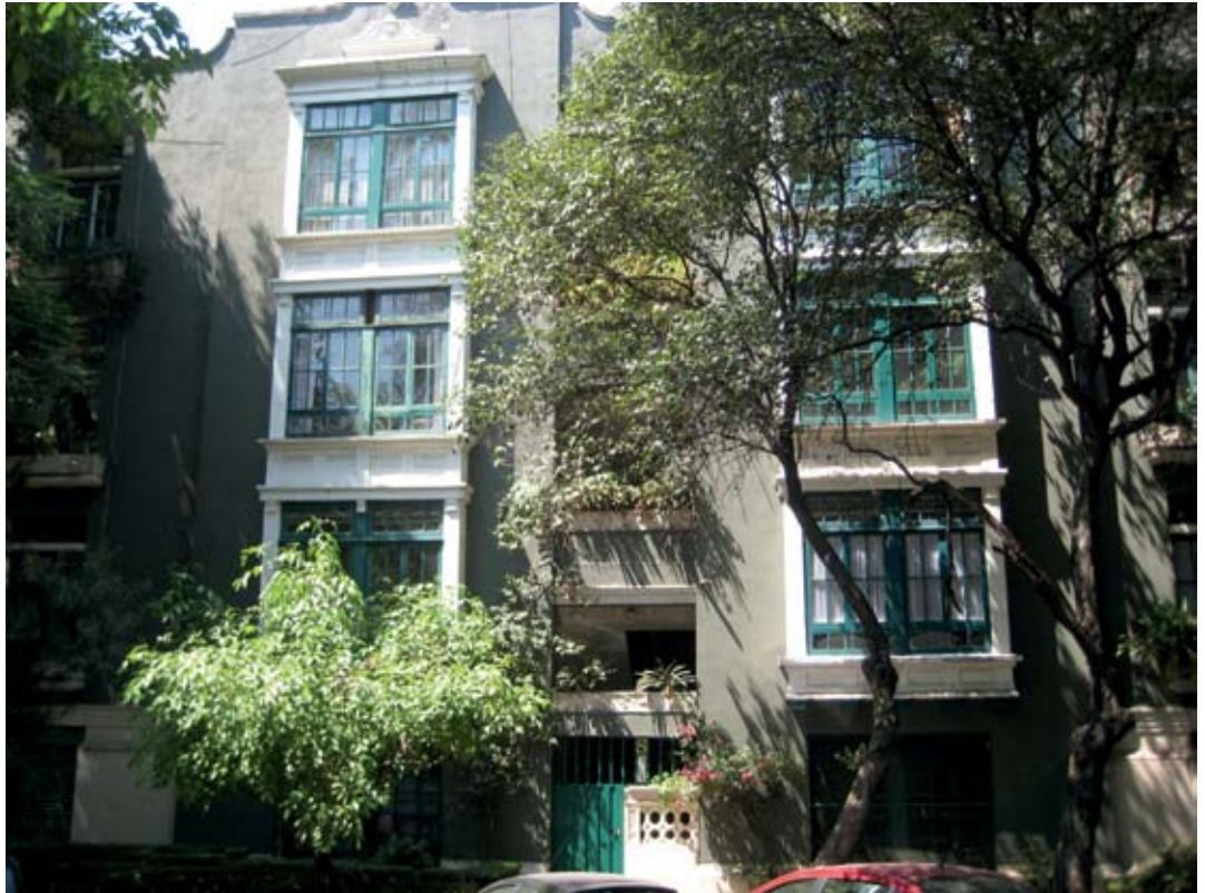
Fachada del ► Edificio Condesa, en la calle de Mazatlán
